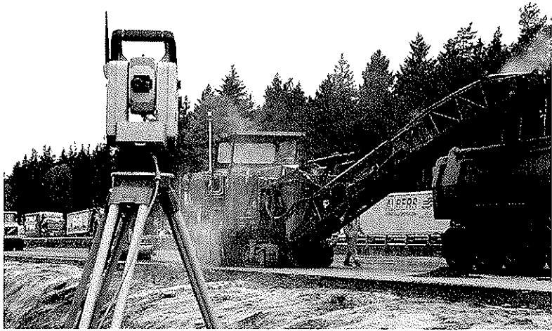
Profilfräsen mit der 3D-Steuerung beim Ausbau der A 1
