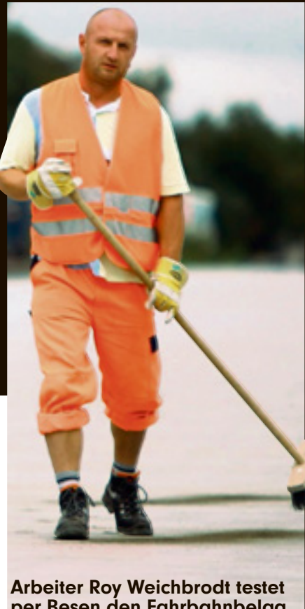
Arbeiter Roy Weichbrodt testet per Besen den Fahrbahnbelag
