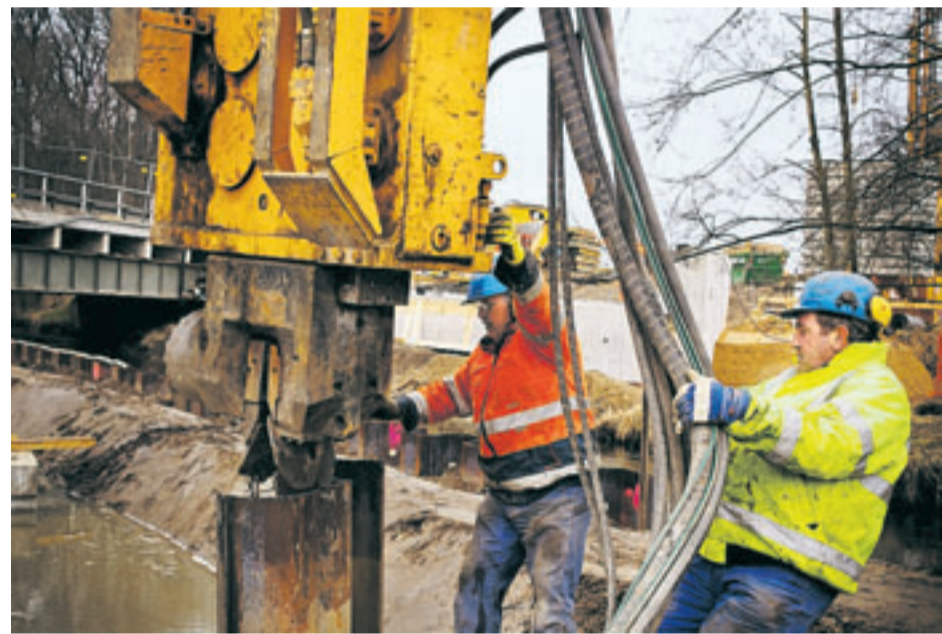
Auch wenn viele der Arbeiten an der Autobahn mit schwerem Gerät erledigt werden, ist Handarbeit unverzichtbar.
