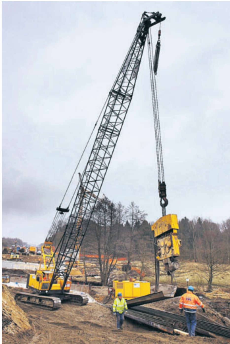
Über- und Untertunnelungen der Fahrbahn stellen bei dem Bauvorhaben große Herausforderungen dar.
