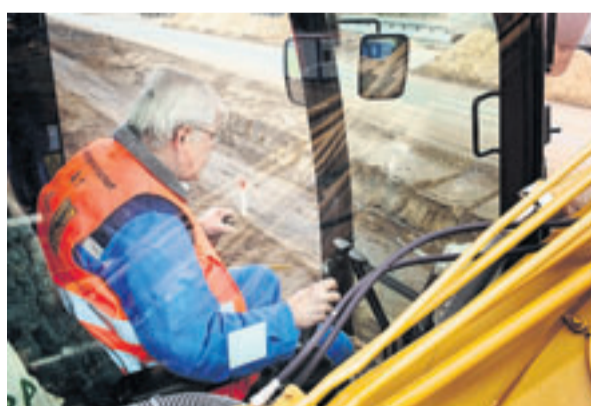
Mit langjähriger Erfahrung und Fingerspitzengefühl arbeitet sich der Baggerfahrer Hermann Rehbock Stück für Stück entlang der Böschung vor.
