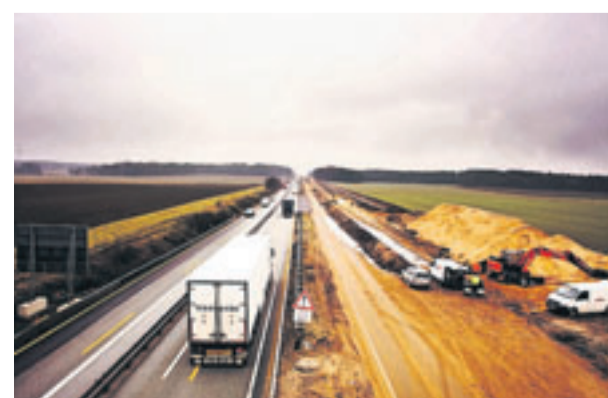
Um Platz für den Ausbau zu schaffen, wird der Verkehr der A1 immer wieder durch verengte Autobahndurchfahrten geleitet.
