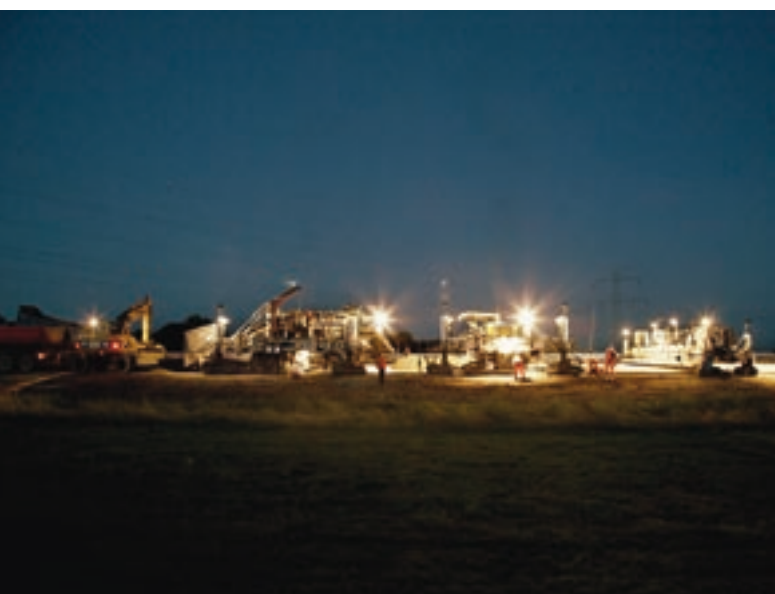
Autobahnbau oft im 24-Stunden-Betrieb
