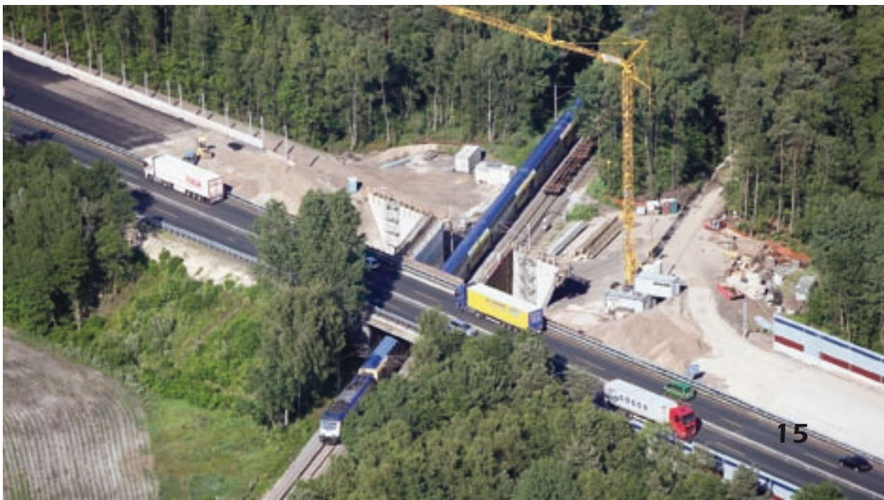
74 Über- und Unterführungen werden erstellt
